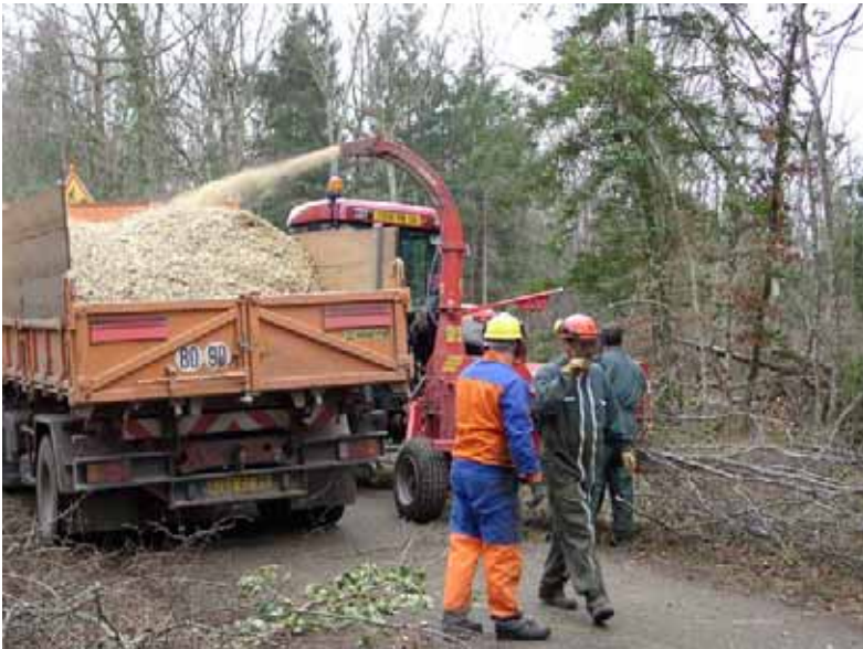
Chantier de déchetage avec la DDE d'Avallon (89) – Valorisation des bois d'élagage routier (photo – PNRM)
