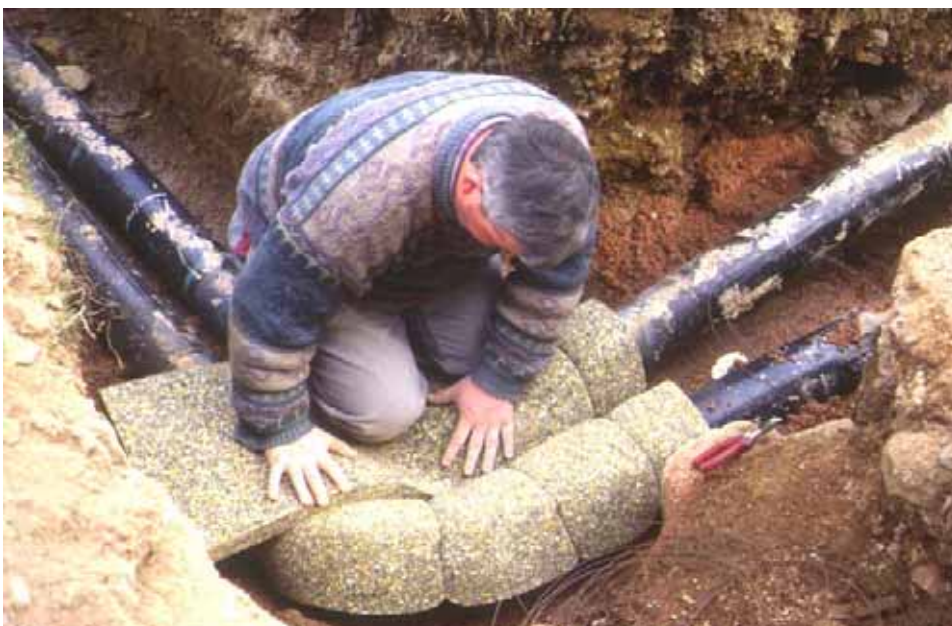
Mise en œuvre du réseau de chaleur (photo – PNRM)
