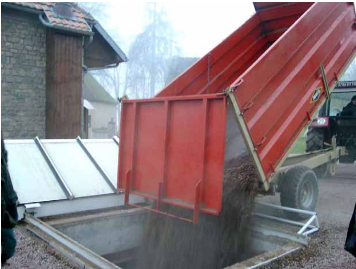
Ensilage du combustible bois (photo PNRM)
